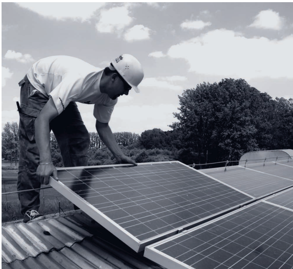
montáž solárních panelů fotovoltaické elektrárny
