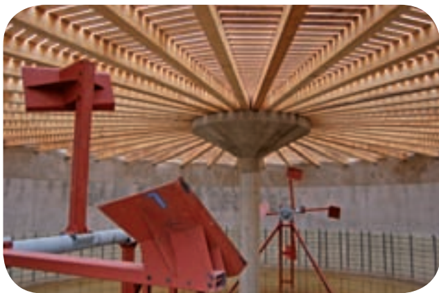
Fermentor se stropem z dřevěných trámů
